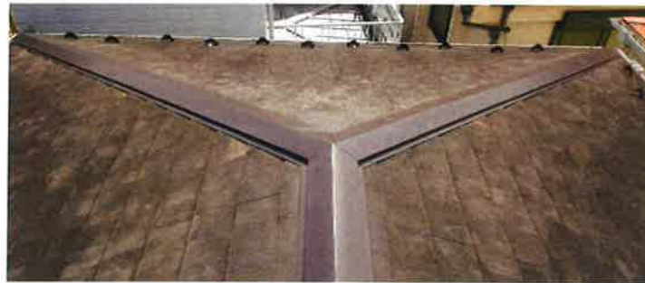
棟板金取替え 下地から直してしっかり固定。
